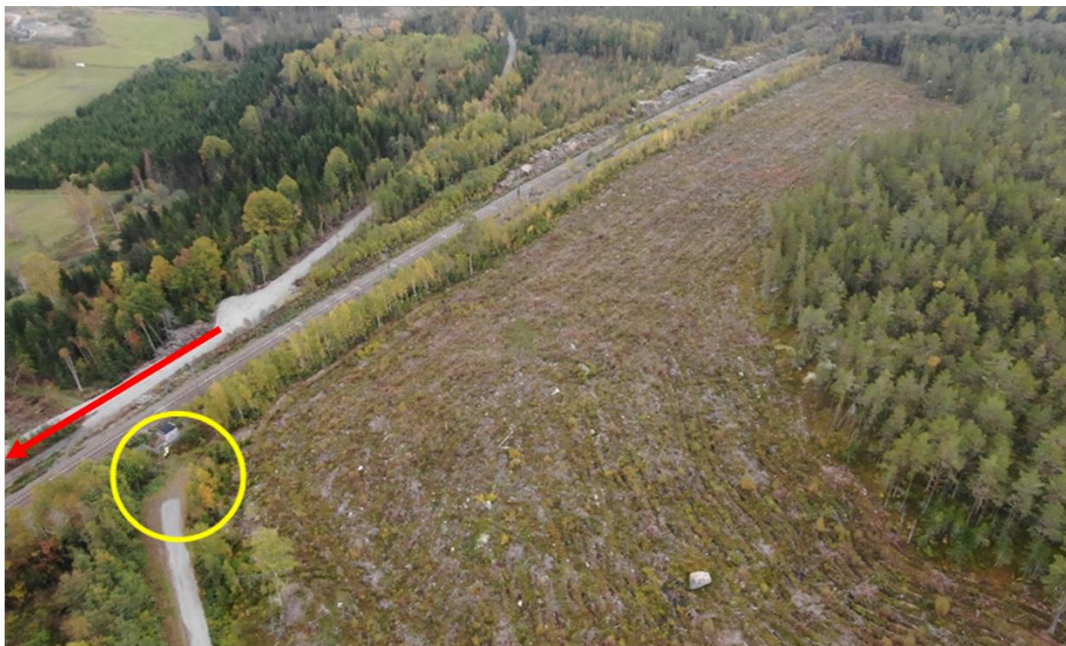
Figur 9. Markområdet söder och väster om olycksplatsen. Gul markering visar ett dike som tidigare gått fullt så att vatten bräddade över vägen. Röd markering visar riktningen mot raset (utanför bild) och tågets färdriktning.
