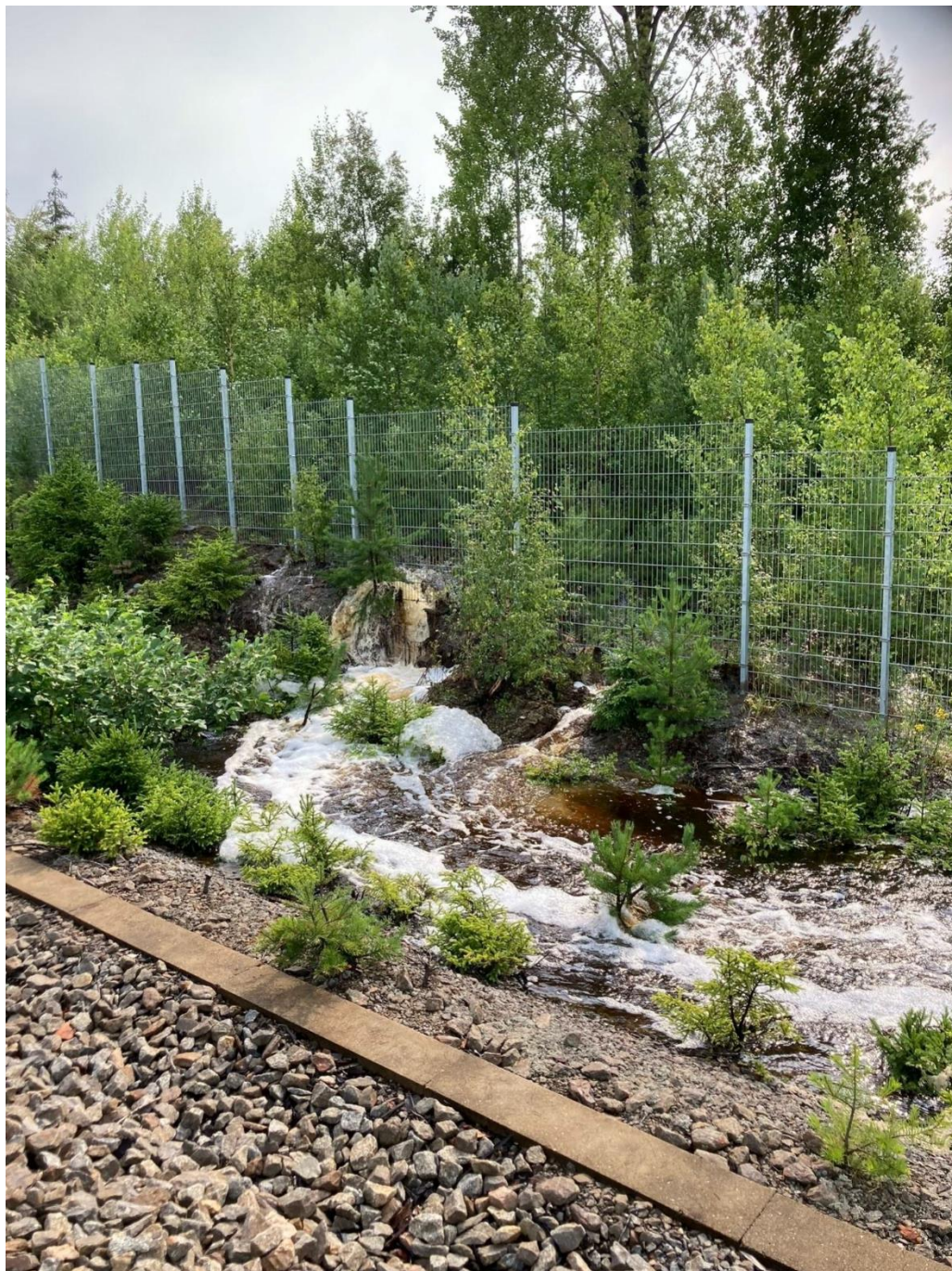
Figur 4. Bilden, som är tagen några timmar efter olyckan, visar vatten som forsar ned från överdikedet mot banvallen. Foto: Trafikverket.
