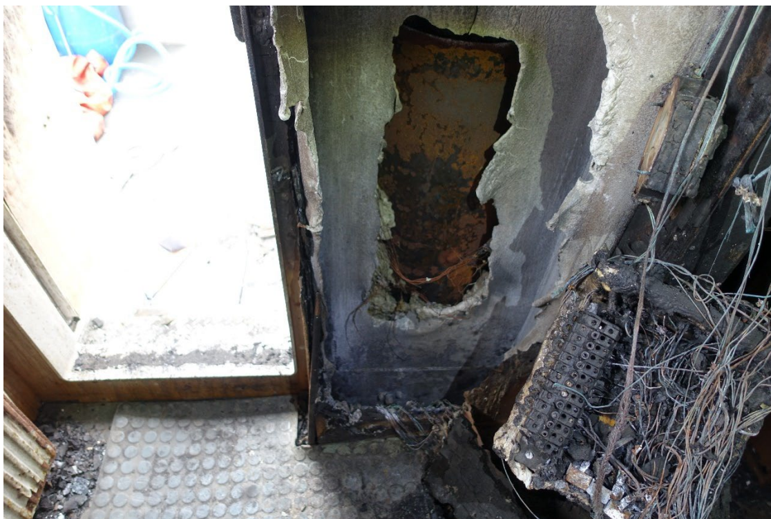
Foto 2. Luftschaktet, samt schakt för avgasröret.
