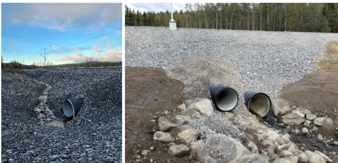
Figur 11. Efter återställning. Nya och kraftiga rörtrummor genom banvallen vid urspårningsplatsen och km 709. I den högra bilden är det högra röret den gamla trumman och det vänstra röret är tillfört för att öka flödet vid stora vattenmängder. Höger foto: Trafikverket.
