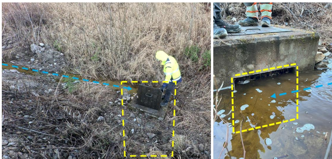
Figur 7. Till vänster en bild från spåret ner mot diket med kassunen markerad i gul ram. Vattnets väg i diket är markerat med blå linje. Till höger framgår att kassunens öppning till stora delar var blockerad av sediment.
