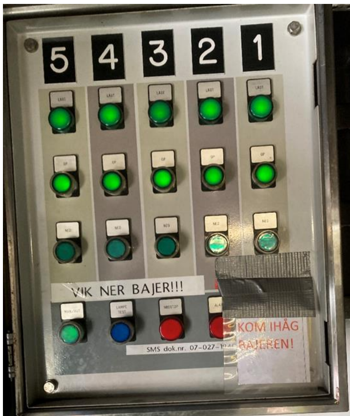
Figur 8. Manöverpanel för automatisk höjning och sänkning av hängdäcket.
