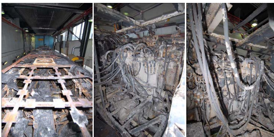
Fig. 8a-c Arbetsmaskinens hydrauliksystem under det glasfiberarmerade taket.
