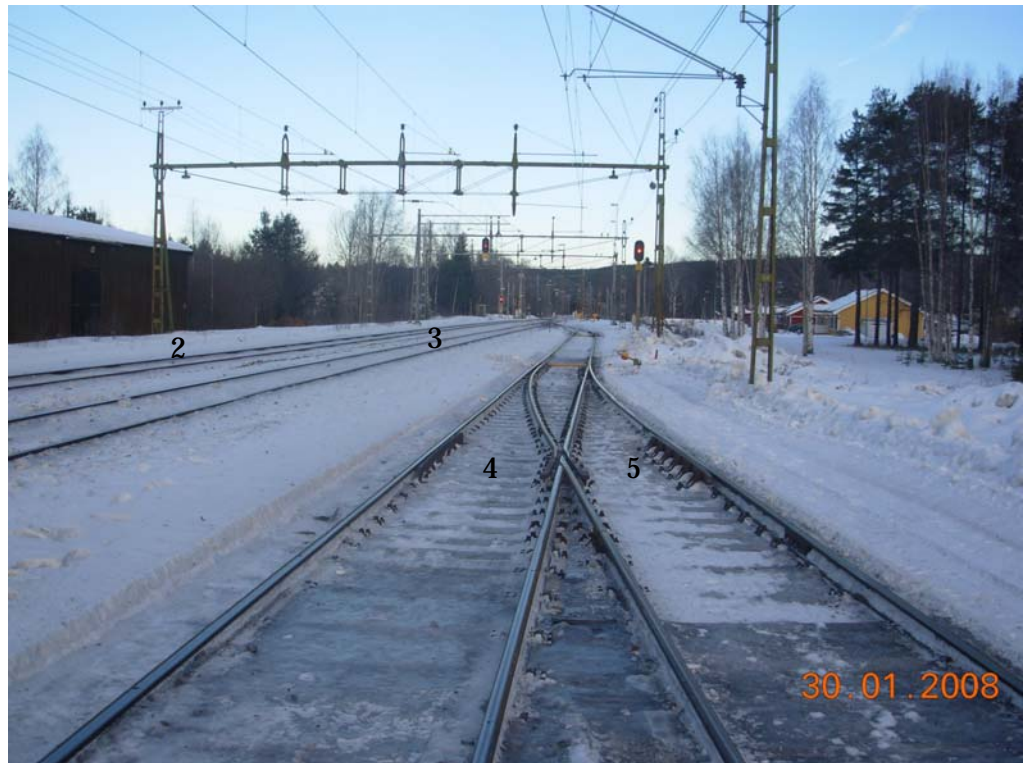
Fig 5. Fotot är taget i riktning mot Ovensjö. Spåren är spår 2 längst till vänster, därefter spår 3 och 4 med spår 5 längst till höger i bild. De sista vagnarna i tåg 9113, som kopplades av, bör ha stannat under den första kontaktledningsbryggan (vid siffran 3). Fotot är taget kl.10.27.
