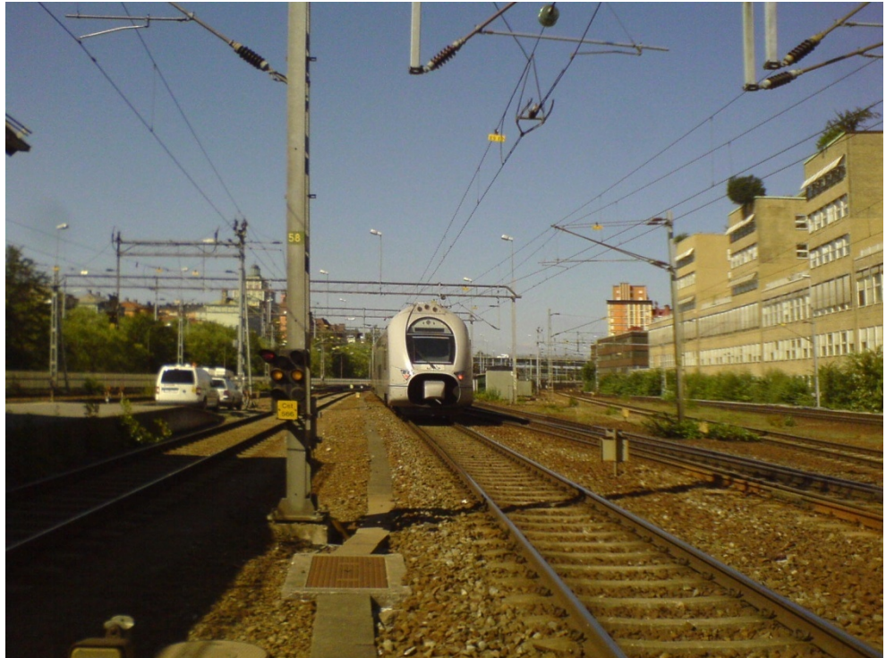
Fig. 6. Huvuddvärgsignal 566 är placerad på stolpen i förgrunden. Bilden är tagen ca 2 timmar efter att tillbudet inträffade. Det röda skenet är placerat upp på vänster sida på signalen. Solen skiner från vänster bildkant och rör sig från vänster till höger på bilden.
