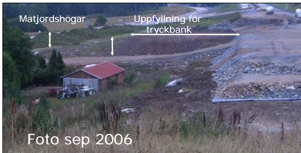
Figur 15. Transportväg och deponerad fyllning i september 2006. Foto i riktning mot söder med del av ny vägbank för E6 till höger på bilden med anslutande transportväg mot vänster/väster.
