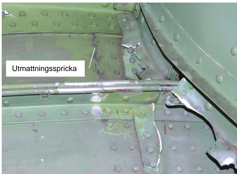
Bild 20. Utmattningssprickor i höger vinge sett inifrån vingen
