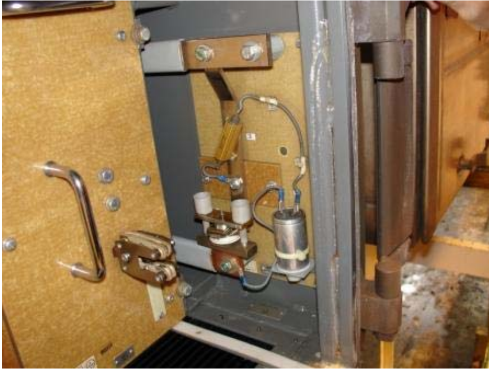
Fig. 20 Frigångsdiod Y1.16.1 med skyddskrets.
