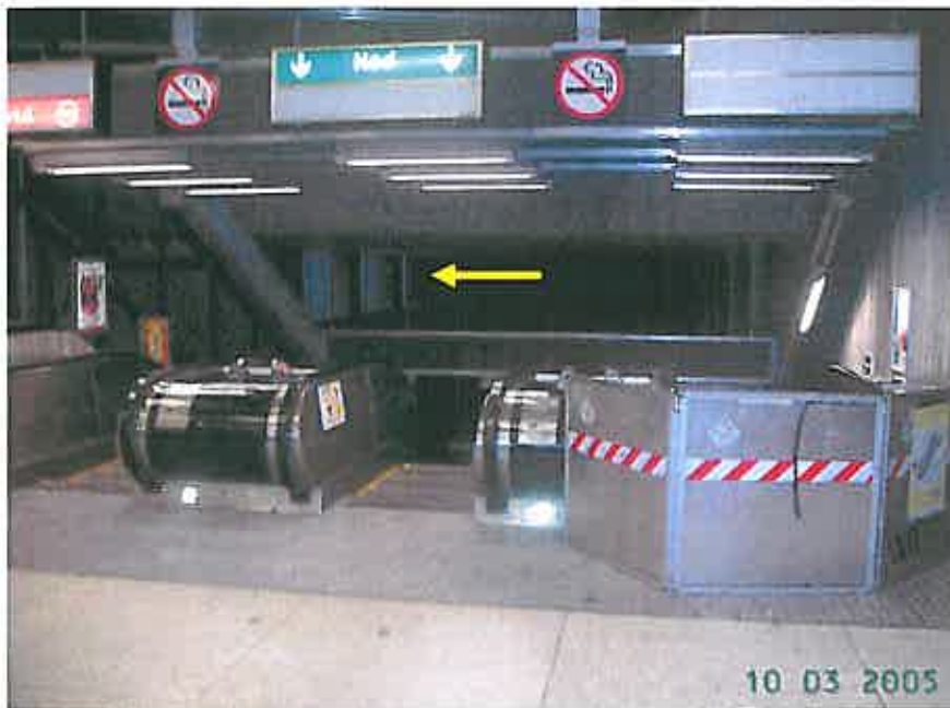
Figur 12 Bilden är tagen från biljett hallen. Till vänster i bild (gul pil) visas de ventilationsöppningar som fanns längst upp i rulltrappan.
