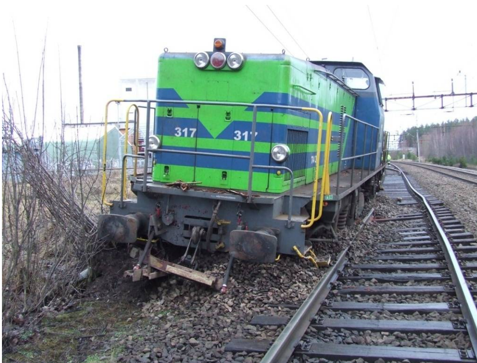
Fig. 3 Bilden visar hur lok 317 stannade och inkräktade på utrymmet för spår 3. Rester av stoppbocken syns i framkant av loket, under buffertarna.
