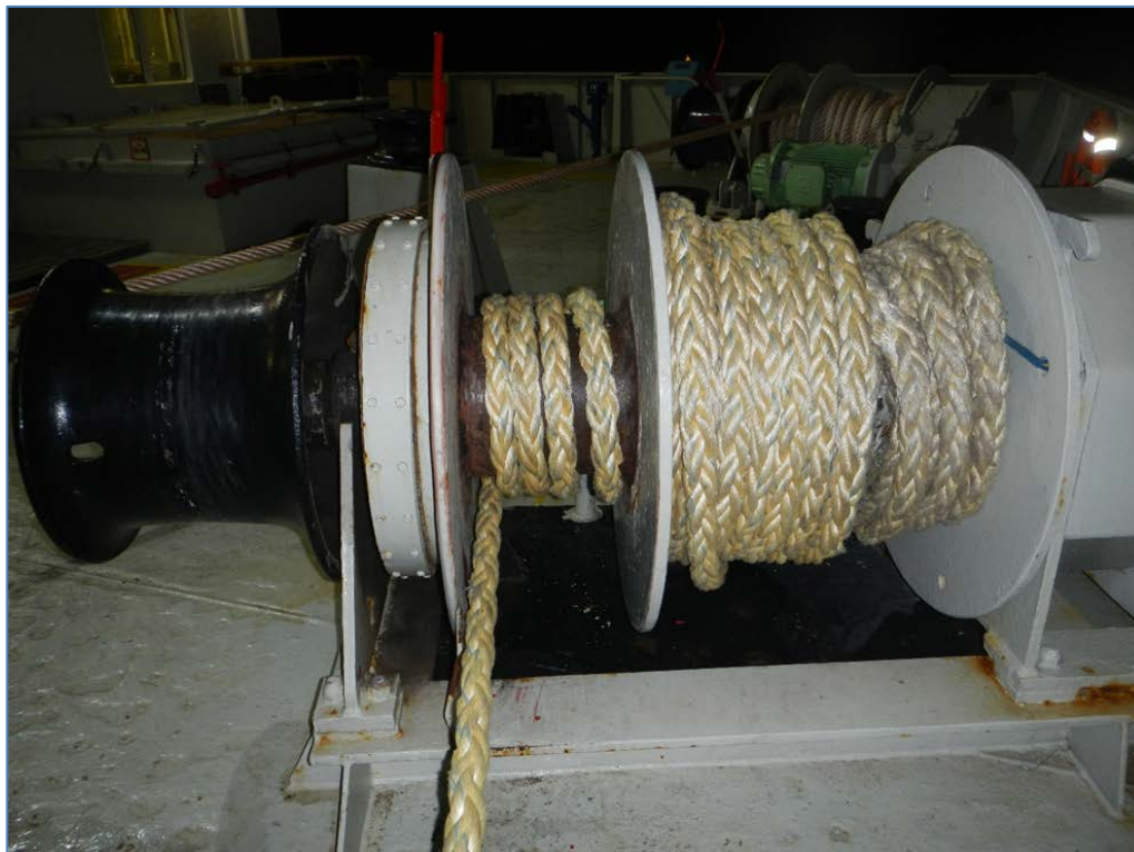
Figur 14. Förtöjningsvinsch – den ordinarie trossen utgående från belastningssidan på vinschen.
