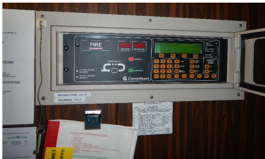
Figur 6. Brandlarmstablån där man kan läsa av vilka detektorer och sektioner som har reagerat. Sådana tablåer fanns bland annat på bryggan och i receptionen.
