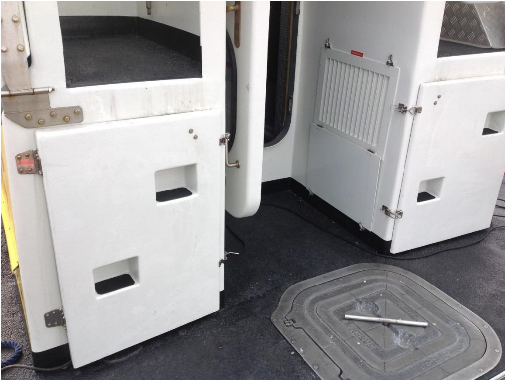
Fig. 5. Ytan på akterdäck, där den saknade personen omhändertogs. Den vid grundstötningen skadade räddningsmannen slog huvudet i ett av låsbeslagen till de vita luckorna som syns på bilden.
