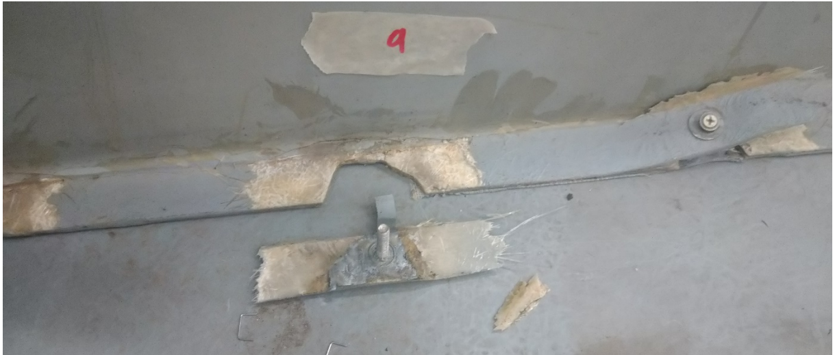
Fig. 3. Exempel på reparation av fästflänsen på babords bänkrad.
