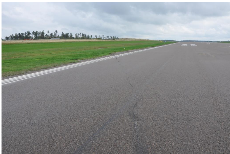
Figur 15. Tydliga vita spår av metall samt gummispår fram till avåkningspunkten.
