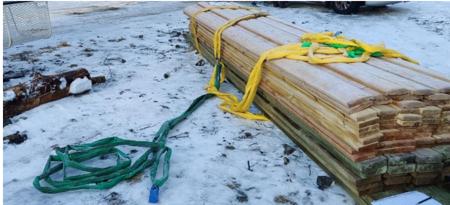
Figur 5. Laststroppar i gult och förlängningsstroppen som är grön till färgen.
