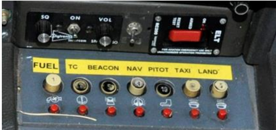
Figur 23. Elektiska panelen för strömställare på SE-MKV vid haveritillfället. Observera att strömställare för minnesåtgärder är avstängda (uttryckt läge).
