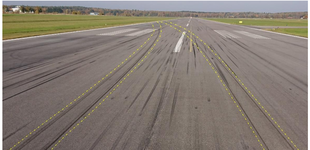
Figur 1. Däckspår i landningsriktningen mot vänster bankant. Foto: Trollhättan/Vänersborgs flygplats.
