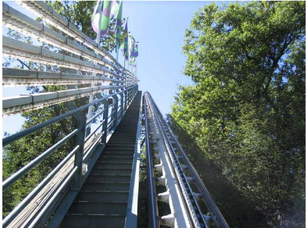
Fig 1. Uppdraget. Kedjetunneln ses i mitten av spåret.
