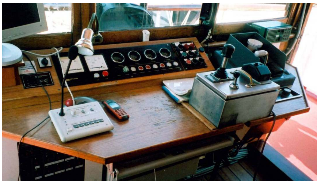
Bild 3. Förkant av styrhytten med styr- och manöverreglage samlade i en box (t.h. i bild) som kunde flyttas med ut till bryggvingarna vid manöver till och från kaj.
