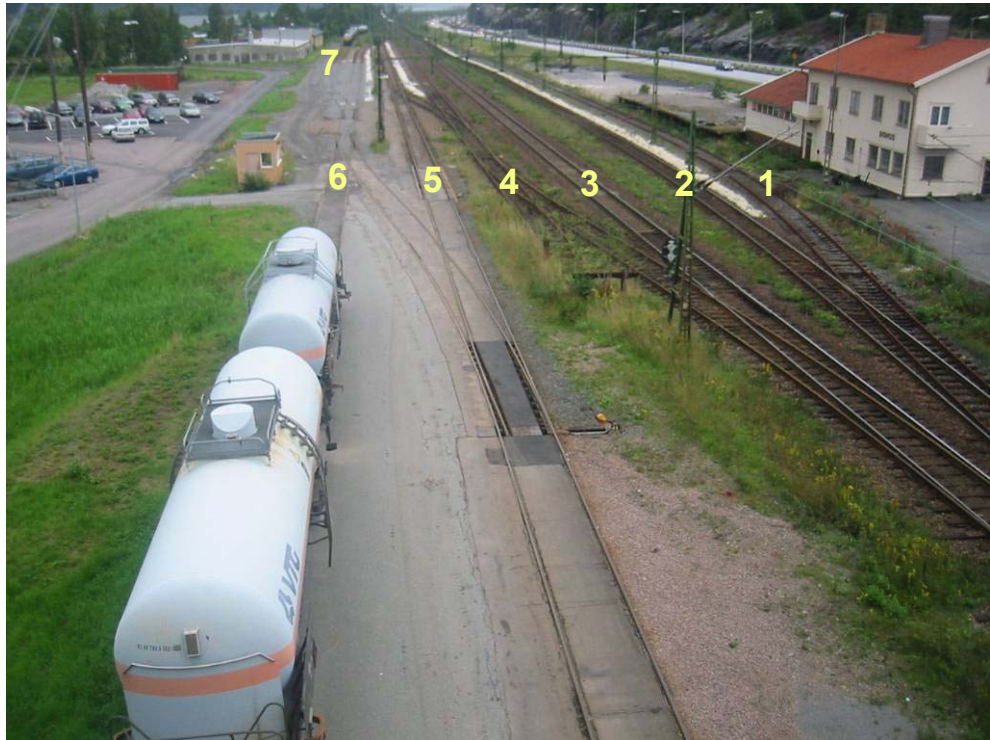
Bangården i Bohus sedd från Jordfallsbron med spårnummer inlagda. Bakom fotografen ligger Eka:s område.
