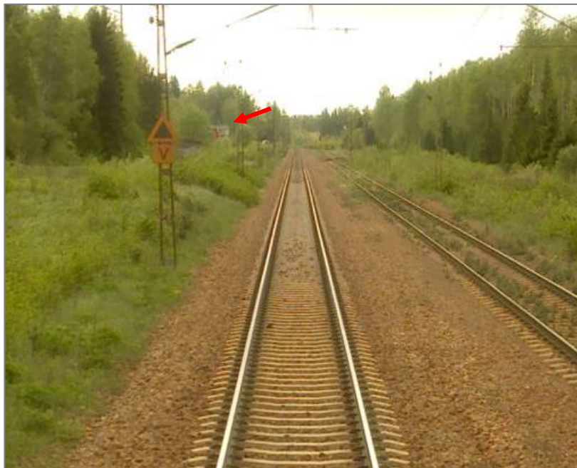
Figur 12. Orienteringstavans placering 600 meter före plankorsningen. Den röda byggnaden till vänster i bild (röd pil) står i höjd med plankorsningen. Källa: Trafikverket.
