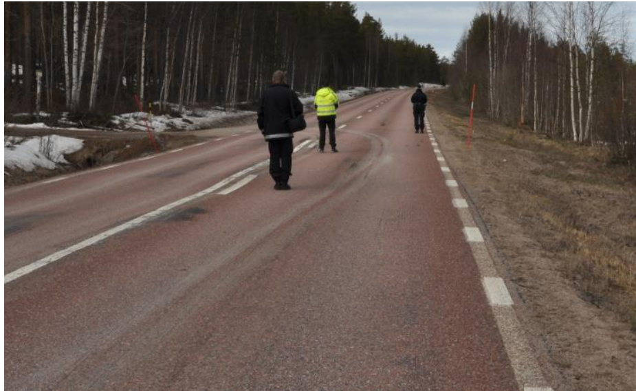
Figur 10. Ojämnheter i vägbanan ca 340 m innan nollpositionen och 480 meter innan slutpositionen. Personerna på bilden är placerade på ojämnheternas dalar.
