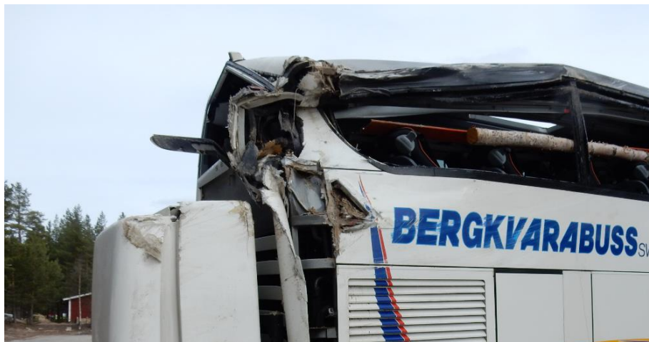
Figur 16. Deformationen på den bakre delen av bussen. Trädet som är inklädat i passagerarutrymmet sattes dock dit för att användas vid bärgningsinsatsen.
