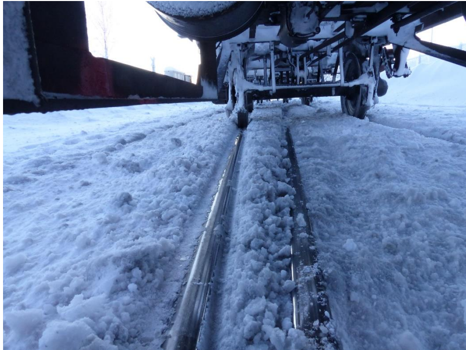
Figur 21. Bild framåt under den fjärde vagnen som visar spåret närmast efter korsningspartiet i växel 12. Foto: Green Cargo.
