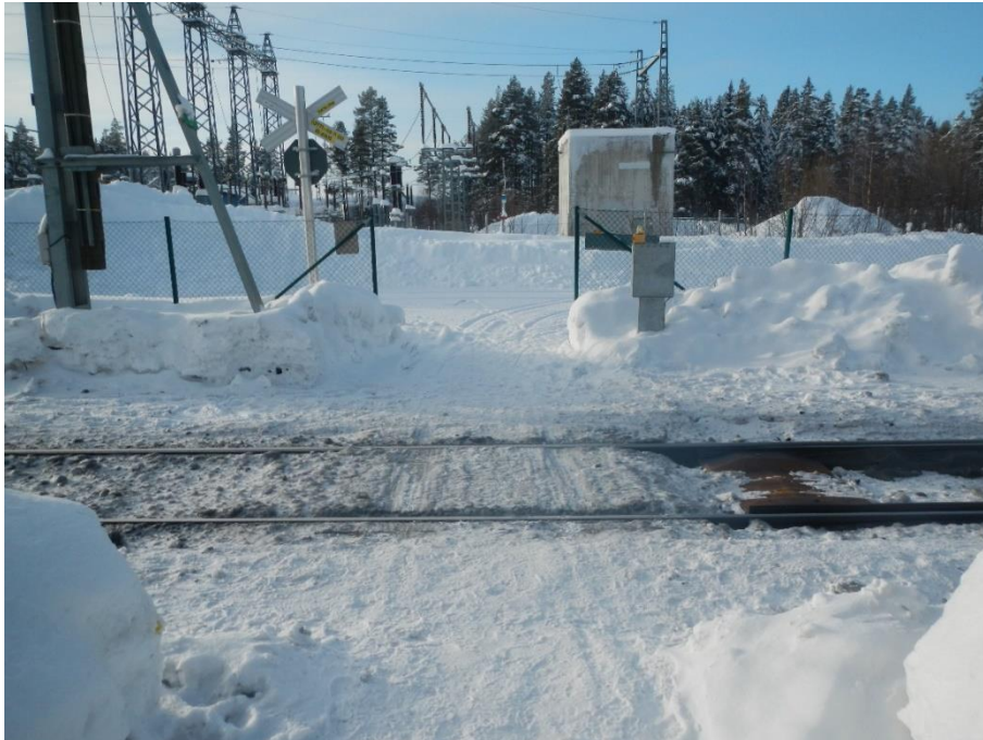
Figur 8. Bild av övergången mellan växel 12 och 13 (med växeltungorna till växel 12 synliga till höger). Fotograferat i samband med haverikommissionens platsbesök den 20 februari 2018.
