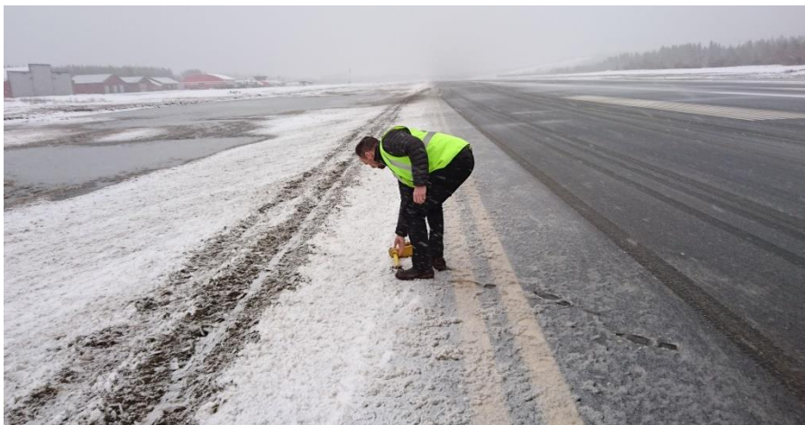
Figur 2. Spår efter flygplanet utanför banan samt det påkörda bankantljuset. Foto: Vilhelmina flygplats. (Fotografiet taget motsatt landningsriktningen).
