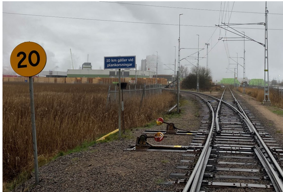
Figur 18 visar skyltning vid färd in på Fabriksspåret från Väröspåret, en generell hastighetstavla om 20 km/tim och en kompletterande blå skylt med texten ”10 km gäller vid plankorsningar”.
