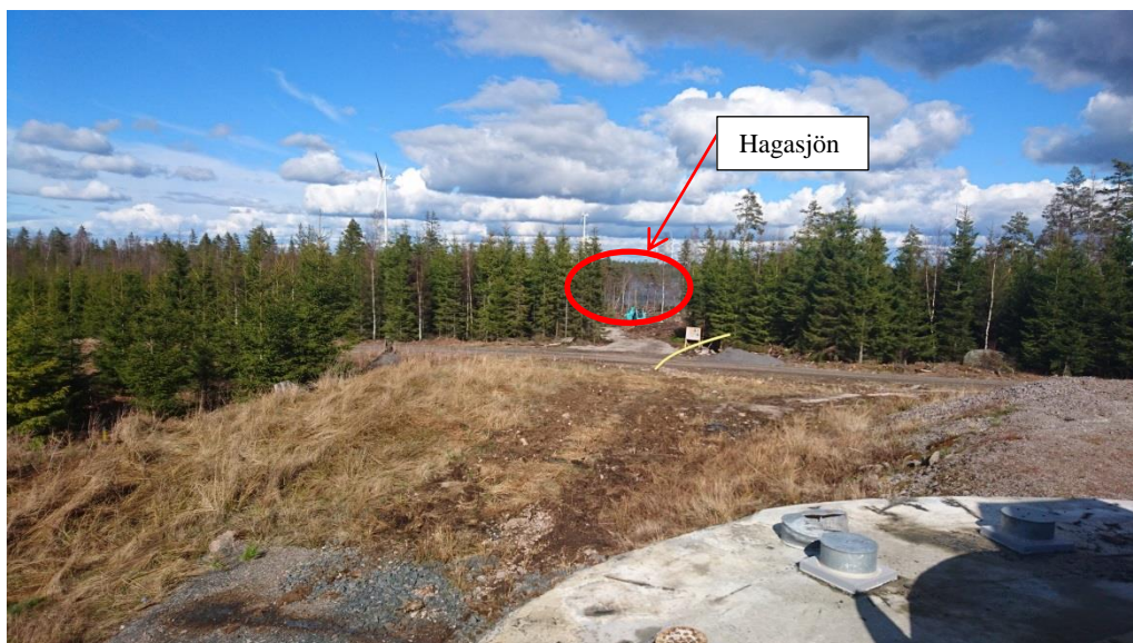
Figur 2. Bilden tagen i fallriktningen, ost/nordostlig, där tornets nedslagsplats framgår av röjningsgatan i trädlinjen.
