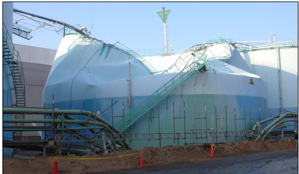
Figur 5. Cistern 436 efter haveriet
