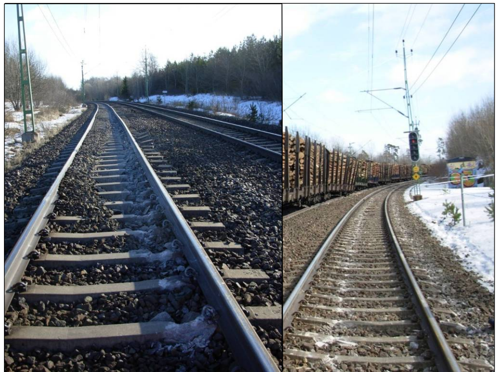
Fig 9. På bilden t.v. syns skador på uppspåret vid den punkt där den senare välta timmervagnen spårade ur. Kilometerstolpe 233 skymtar i bakgrunden. Ett rälsbrott uppstod på den högra rälen, i bildens bortkant. På bilden t.h. syns urspårningsskador på nedspåret från X14-motorvagnen. Mellanblocksignal Vsd N12 syns på kontaktledningsstolpen.
