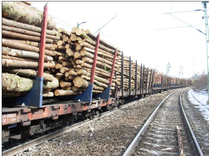
Fig 5. Nedspåret med urspårningsskador samt urspårade timmervagnar på uppspåret. Bilden är tagen i riktning mot Linköping med det urspårade resandetåget bakom fotografens rygg.
