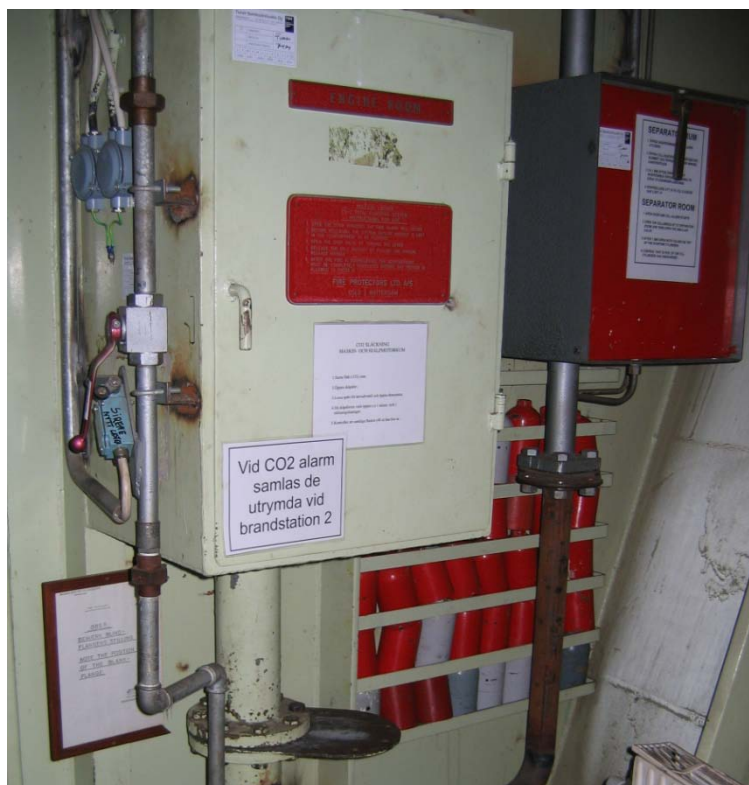
Figur 11 Utlösningsskåp för CO 2 till maskinrum. Nederst i bilden syns svängflänsen till huvudlinan.
