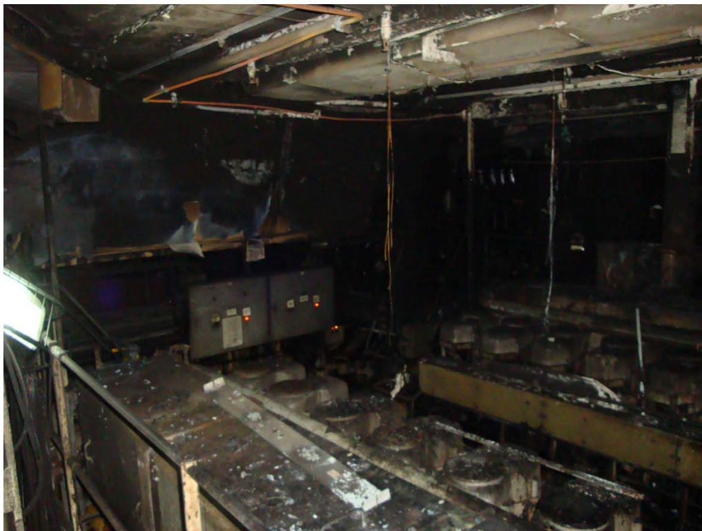
Figur 4 HM1 och HM2 efter branden.
