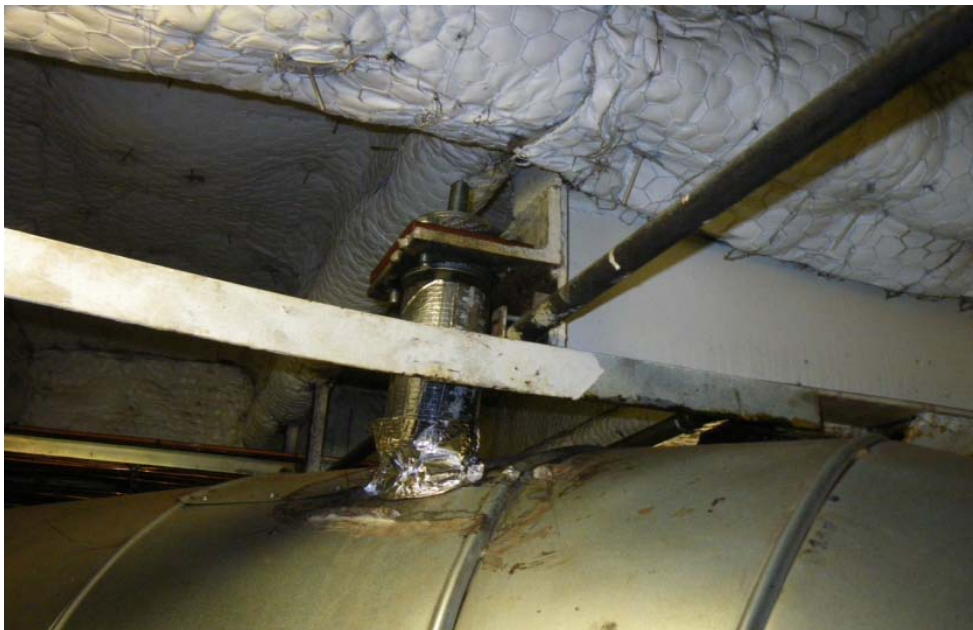
Figur 24 Upphängning av avgasrör. Bilden är tagen efter reparation då stagen har försetts med isolering.
