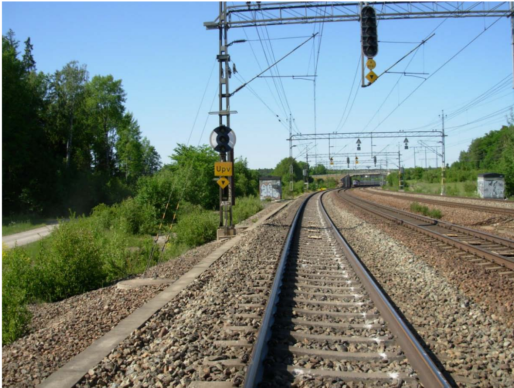
Fig. 2 Bild på urspårningsmärken. Tåget har stannat under viadukten längst bort i bilden.
