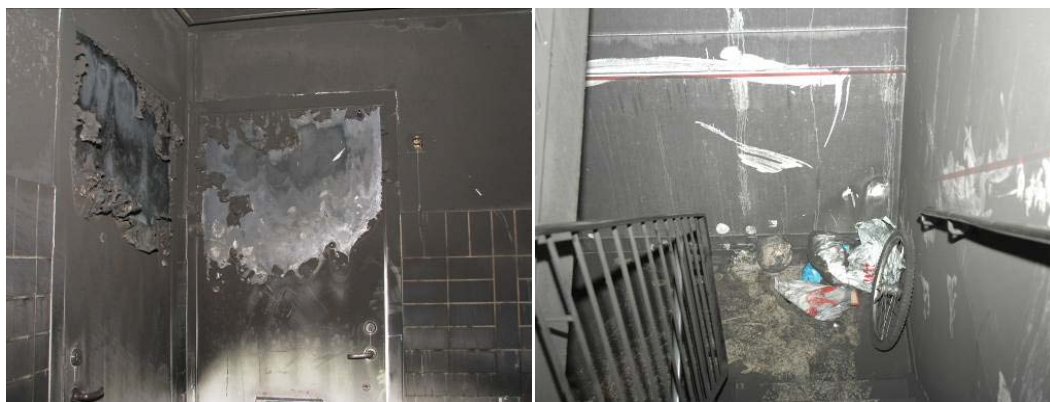
Fig. 20a-b Värmepåverkan på dörrarna mitt emot brandlägenheten. Trappavsatsen mellan plan 3 och 4 med uppställda föremål.
