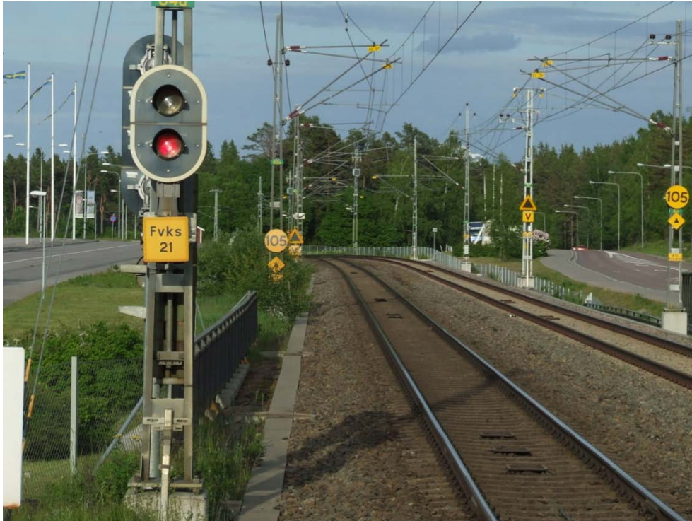
Fig 2. Signal Fvks 21 på Furuvik södra som tåget passerade när den visade stopp.
