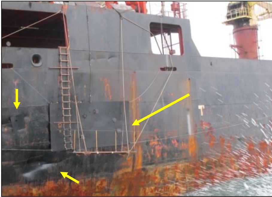
Bild 4: Tillfällig reparation av bunkeroljetank nummer 1 på styrbord sida
