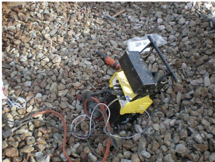
Fig. 5. Bild på det pinnlödningsaggregat (SAFETRACK S30 XC) som användes när olyckan inträffade.
