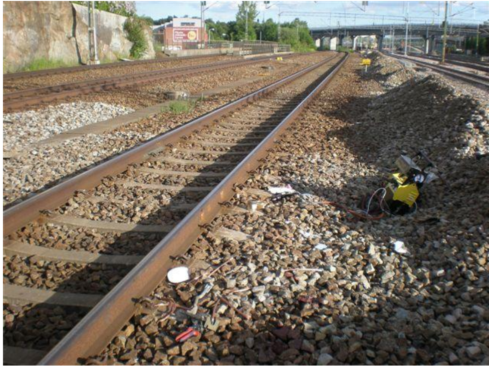
Fig. 4. Bild från olycksplatsen. Olyckan inträffade på spåret närmast till vänster i bild och tåget rörde sig i riktning mot kameran. Uppe till höger i bild finns SWB-viadukten där spåren går mot Sundbyberg.
