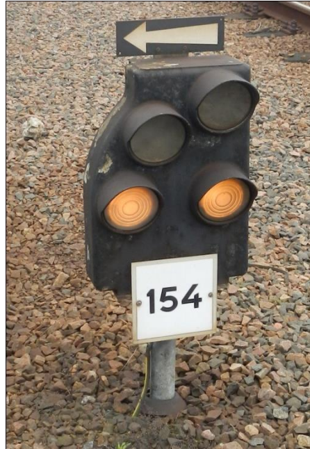
Figur 4. Växlingsdvärgsignal 154 med pilskylt. Foto: SHK.
