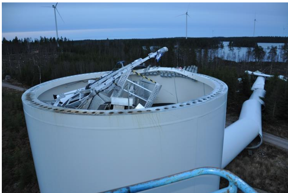
Figur 5. Fläns 1, det undre segmentet. Foto: Vestas Wind Systems A/S.
