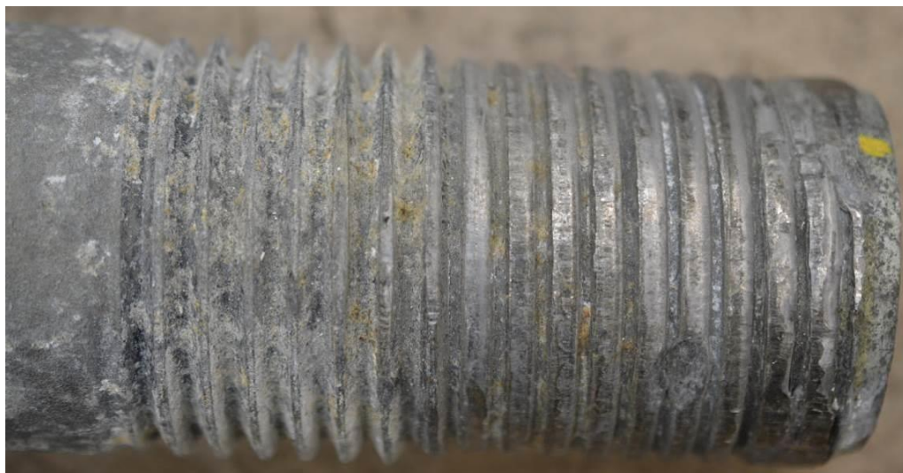
Figur 21. Skruv A med avskjuvade gängor.
