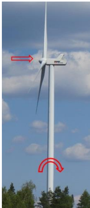
Figur 8. Illustration av horisontell trustkraft på turbinen och böjmoment i tornet, som i huvudsak orsakas av trustkraften.
