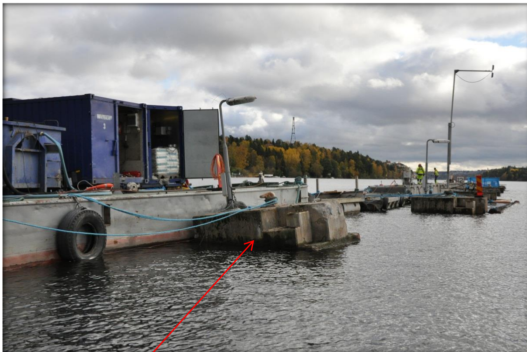
Fig. 4. Påseglad dykdalb som flyttats ca 1,5 m ur sitt läge.
