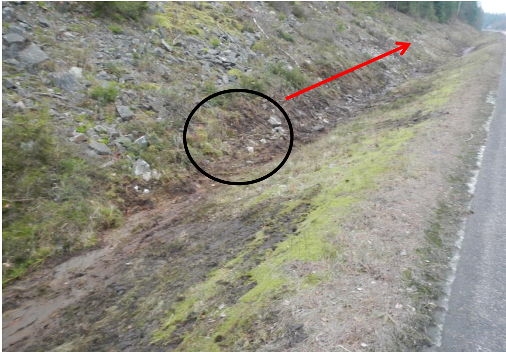
Figur 8 - Den svarta ringen markerar det kraftigare avtrycket i ytterslätten och den röda pilen den sträcka där det återfanns kantstötta stenar, omvälvd jord, krossat glas och växtmaterial.
