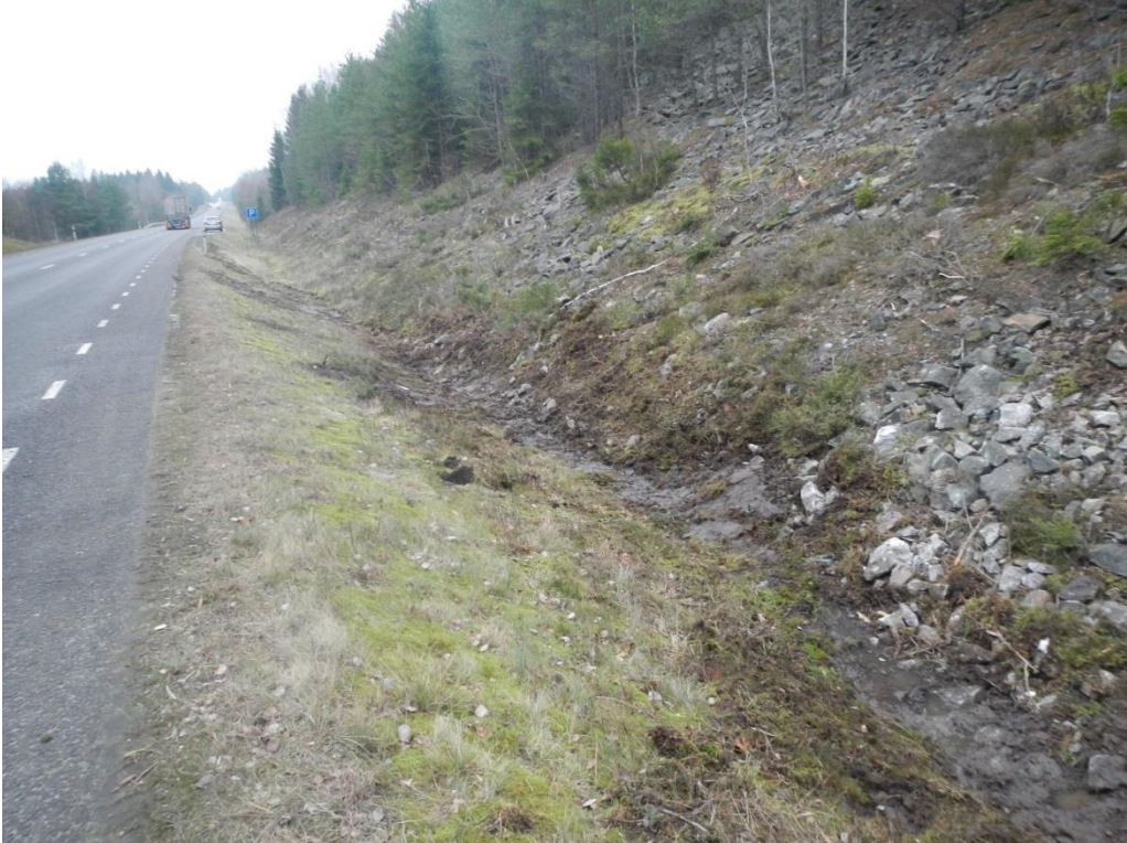
Figur 5 – Inner- och ytterslänt där bussen körde av vägen på riksväg 27. Bilden är tagen mot bussens färdriktning.
