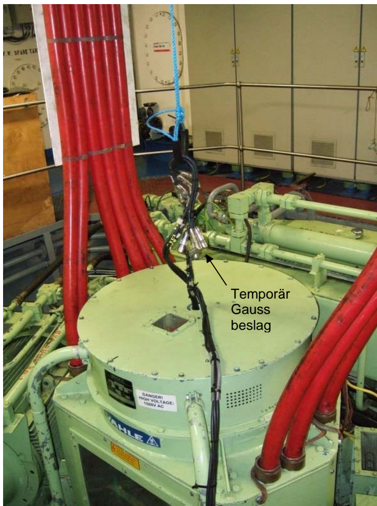
Fig 7b. Närbild på det provisoriska gaussändararrangemanget
