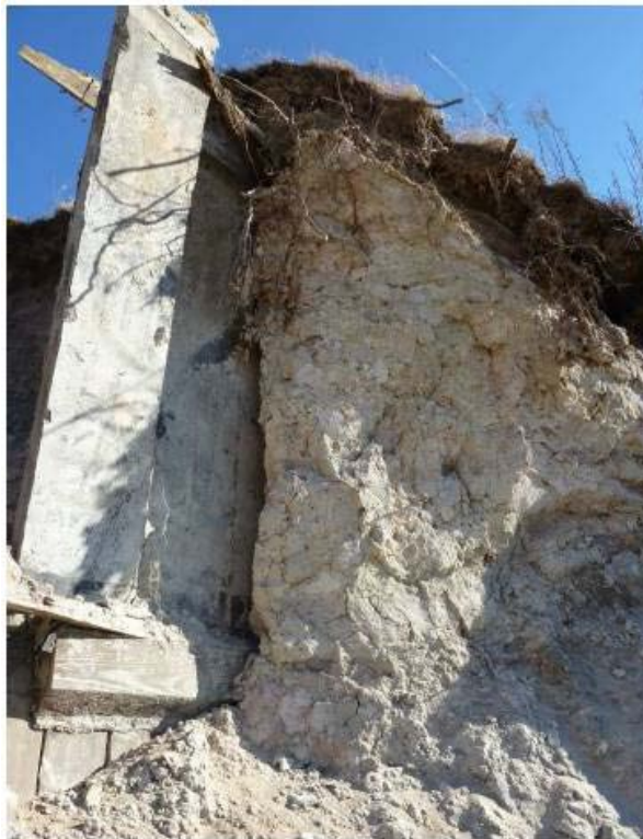
Fig. 13 Delar av täckärnan i mittenfyllningsdammen. Materialet är kiselgur. Foto: SGU.
