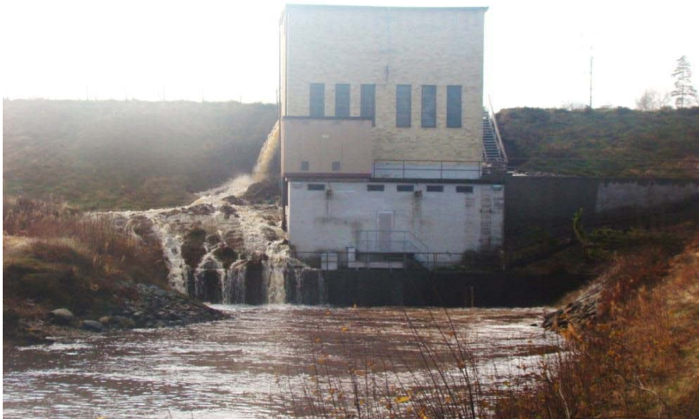
Fig. 5 Foto taget omedelbart före dammbrottet med strömmande vatten vid sidan av kraftstationen. Foto: Konstantin Jaroslavtsev.
