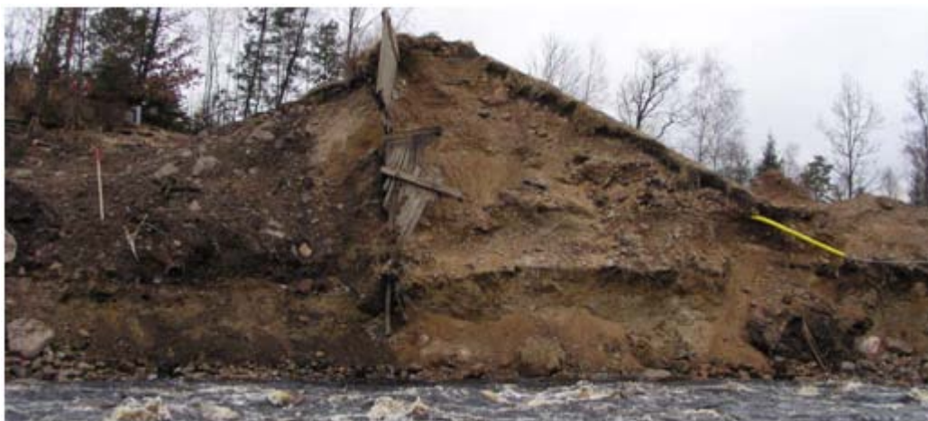
Fig. 9 Bild på vänster fyllningsdamm tagen den 29 mars 2011. Spontväggen med betongplank överst och den påskarvade träsponten därunder. Gränsen mellan dammfyllning och naturlig markyta syns tydligt.
