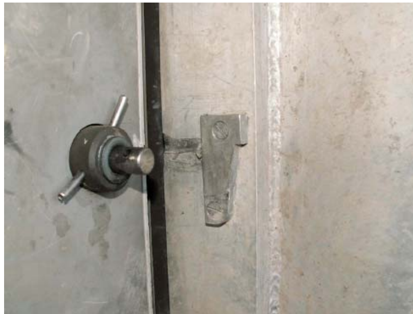
Fig. 15 Mittersta dörrvredet med låshandtaget demonterat. I dörrkarmen syns den djupa ränna som den avbrutna tappan har lämnat.
