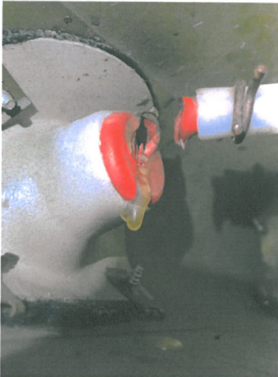
Fig. 3, Avbruten koppling mellan stallvarnarens horn och givare
