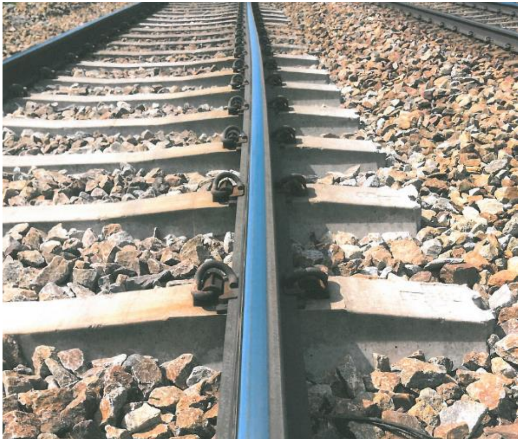
Figur 6. Ballastsektion som av Sweco Rail AB beskrivs som "inte fullgod". OBS ej från olycksplatsen, men annan plats i nedspåret, km 477+240. Visas som exempel.
