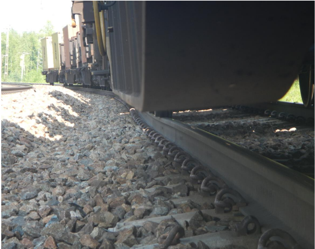
Figur 2. Utknäckning av spåret under ej urspårade vagnar.
