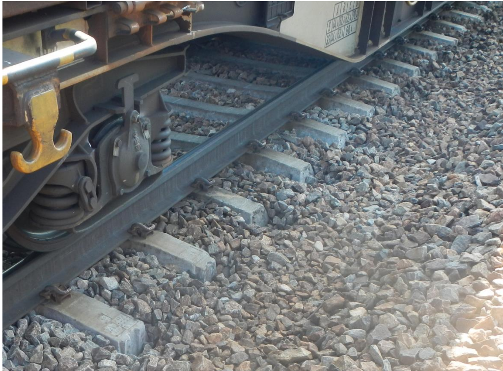
Figur 4. Nedspårets insida vid samma punkt som visas i figur 5.
