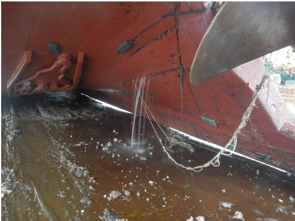
Figur 8. Bordläggning till maskinrummet på SOLVÅG AV GLOMMEN.
