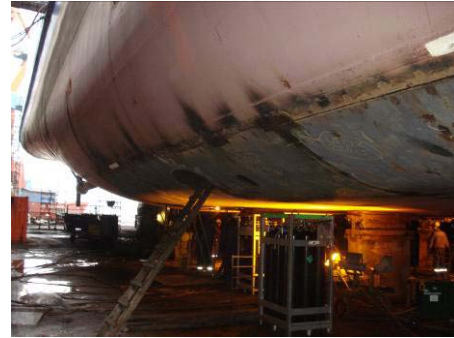
Förnyad bordläggning spant #60-#89
