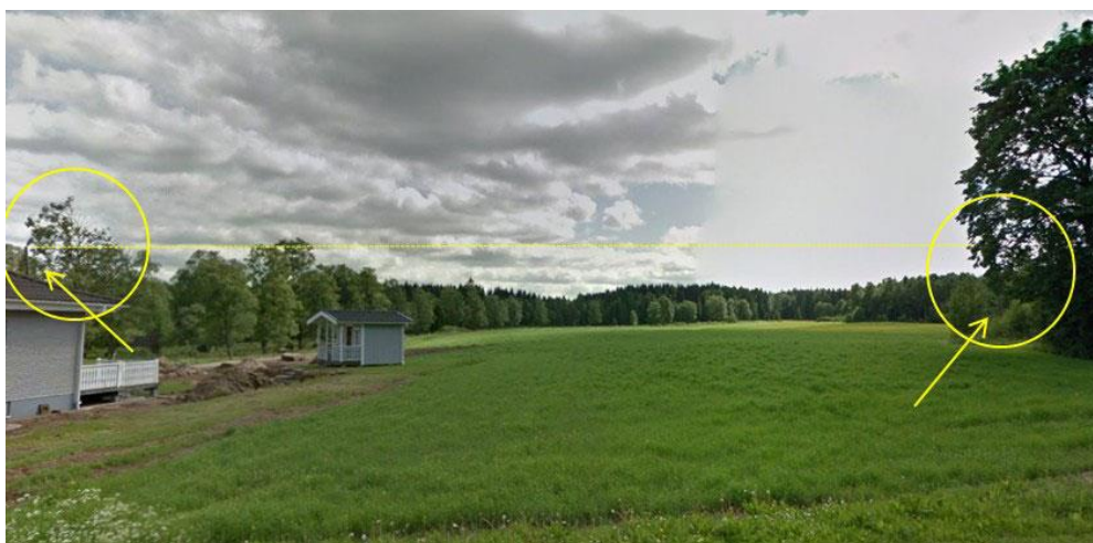
Figur 2. Utlandningsfältet från inflygningsriktningen. Elledningen är markerad med gul streckad linje och området där elstolparna står är markerade med gul cirkel (gula pilar visar delar av stolpar). Foto: Google Earth™
