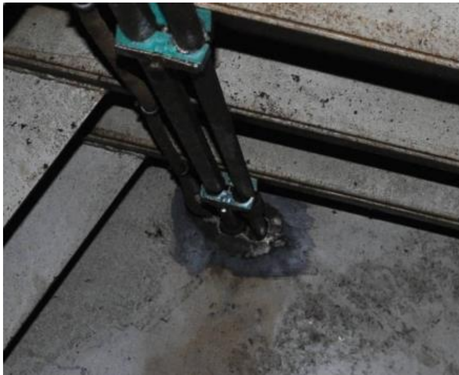
Figur 24. Skottgenomföring för hydraulrör.
