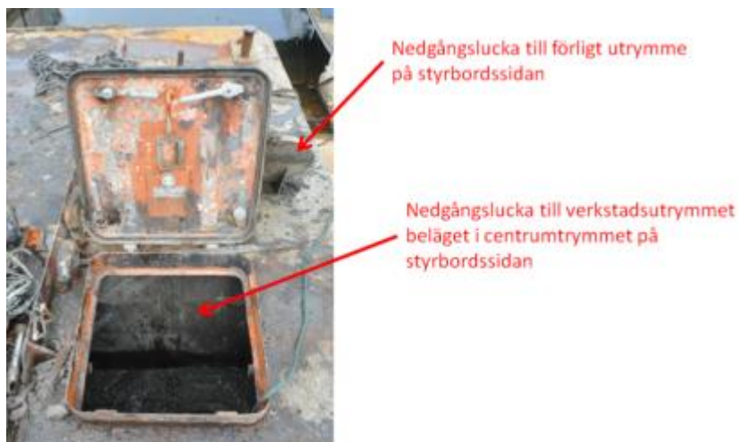
Figur 15. Nedgångsluckor på styrbordssidan i däckets förliga del.
