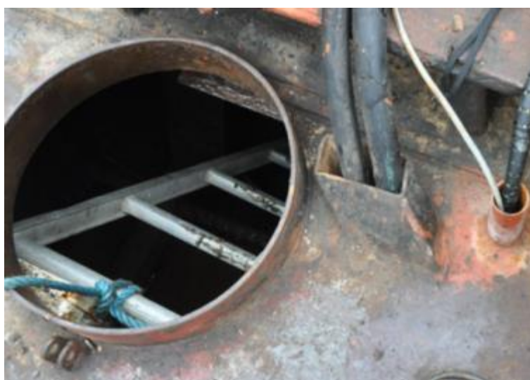
Figur 17. Nedgångslucka och däcksgenomföringar på babordssidan.
