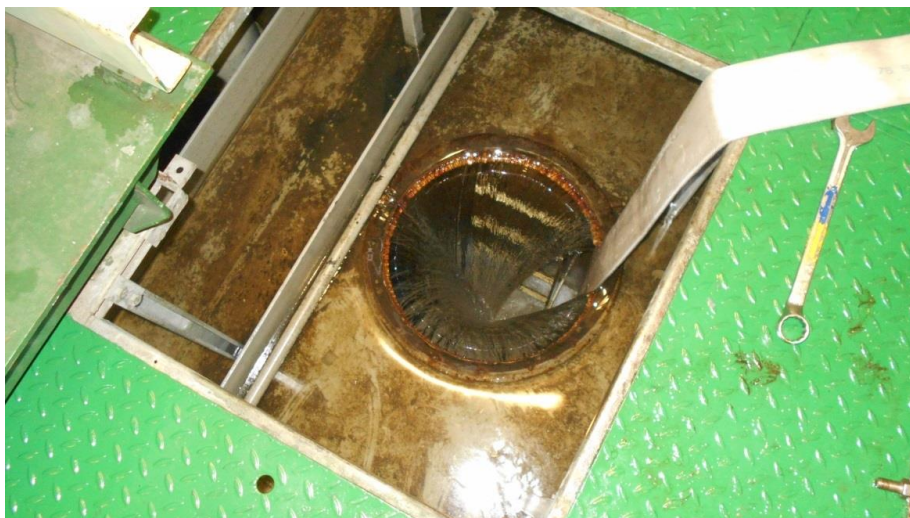
Fig. 19. Genom att denna manlucka öppnades trots att vattnet steg i rummet, kunde vattnet ledas bort från pumprummet. Bild: Stena Line.
